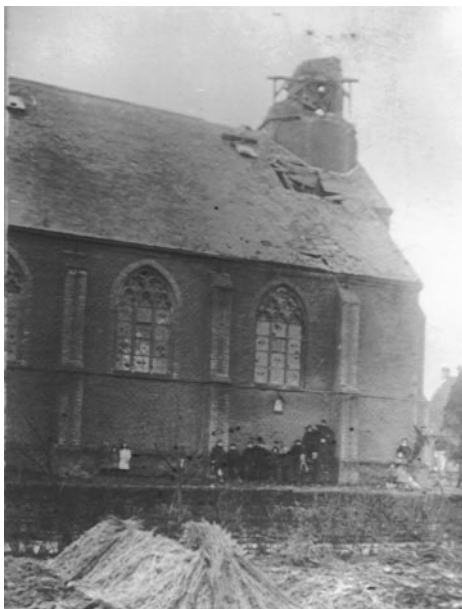
Poesele kerk gezien vanuit het noorden na het opblazen van de toren door de Duitsers op 18 oktober 1918. (Verzameling André Bollaert)
